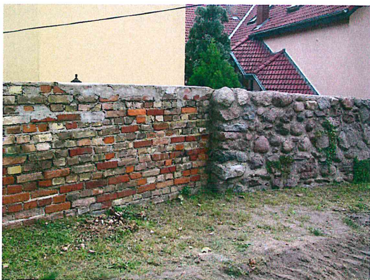
FOT.3. ZARYSOWANIE MURU CEGLANEGO DO SPIĘCIA PRĘTAMI HELFIX W CO DRUGIEJ SPOINIE
