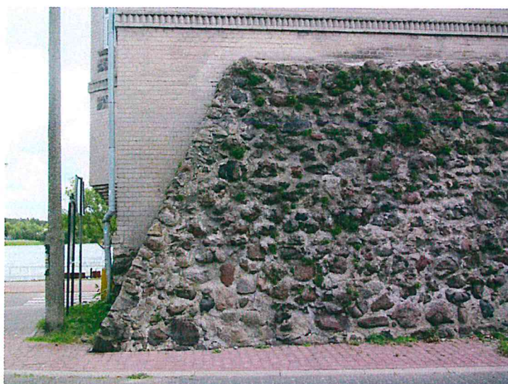
FOT.12. SPOINA CEMENTOWA DO WYMIANY NA TRASOWĄ, ROŚLINNOŚĆ DO USUNIĘCIA
