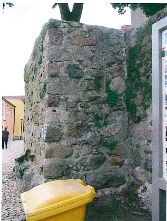
FOT.10. ZARYSOWANIA MURU SPOWODOWANE ROZSADZANIEM GO PRZEZ KORZENIE DRZEWA, ZARYSOWANIE NALEŻY SPIĄĆ PRĘTAMI SYSTEMOWYMI
