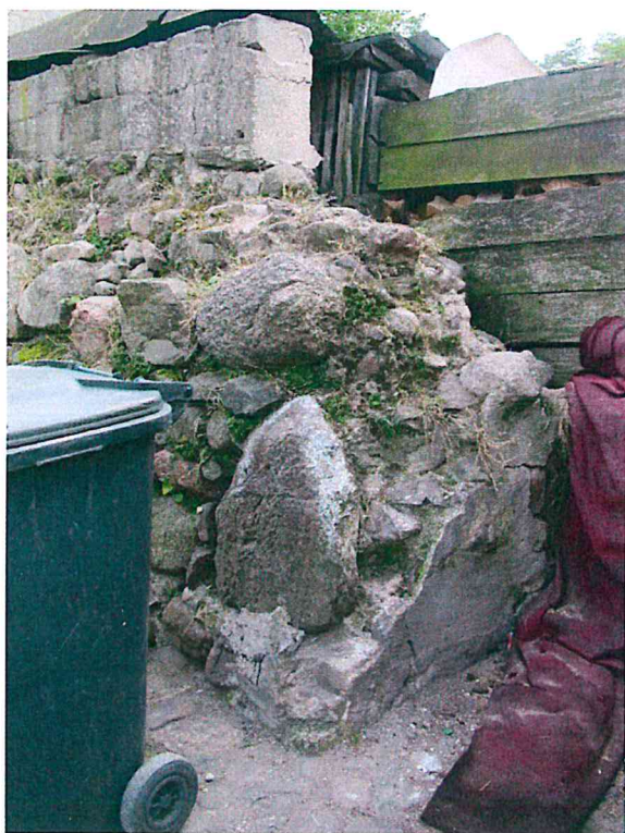
FOT.14.POCZĄTEK IV FRAGMENTU MURU DO PRZEMUROWANIA.
