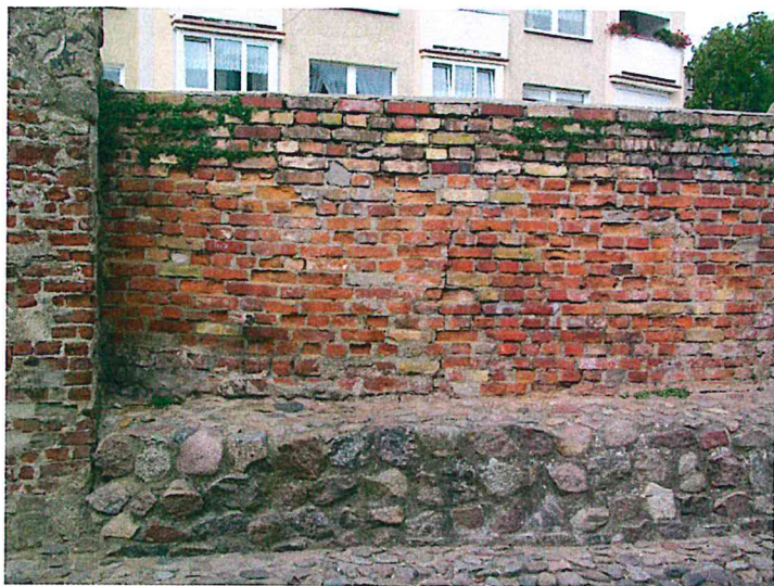
FOT.5. ZARYSOWANIE MURU CEGLANEGO DO SPIĘCIA PRĘTAMI HELFIX W CO DRUGIEJ SPOINIE
