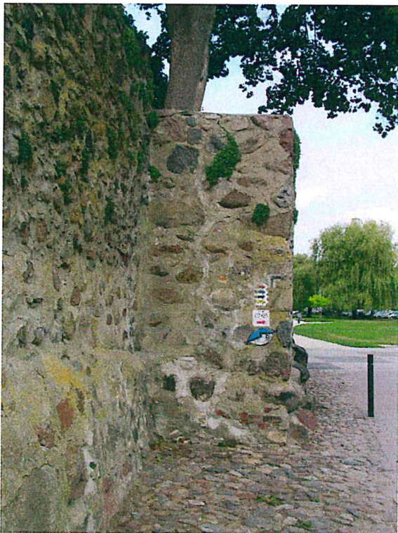
FOT.8.ZARYSOWANIA MURU SPOWODOWANE ROZSADZANIEM GO PRZEZ KORZENIE DRZEWA
