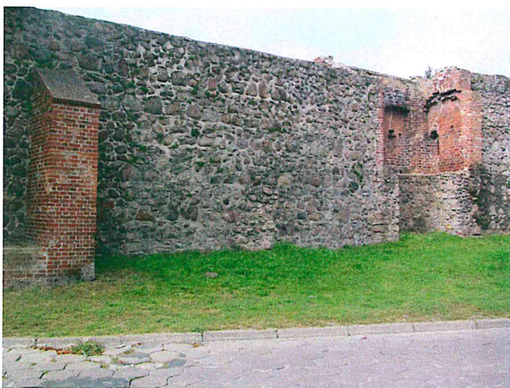
FOT.16.SPOINA CEMENTOWA DO WYMIANY NA TRASOWĄ
