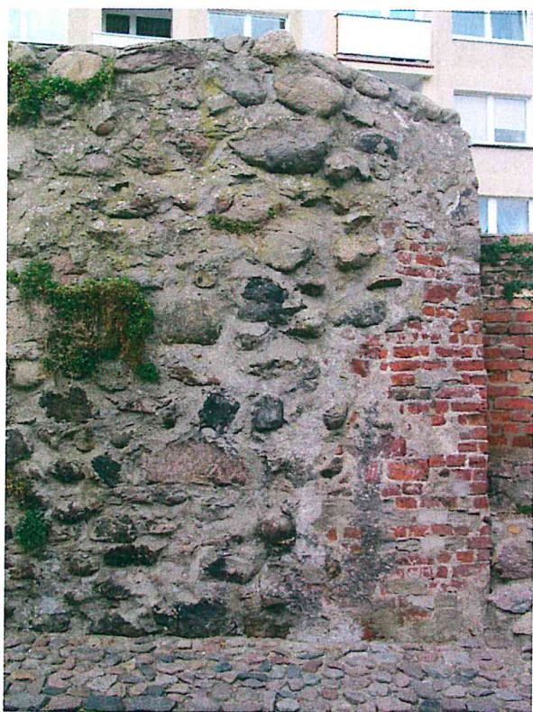
FOT.4.SPOINY DO WYMIANY, NA CAŁEJ DŁUGOŚCI MURU, ROŚLINNOŚĆ DO USUNIĘCIA
