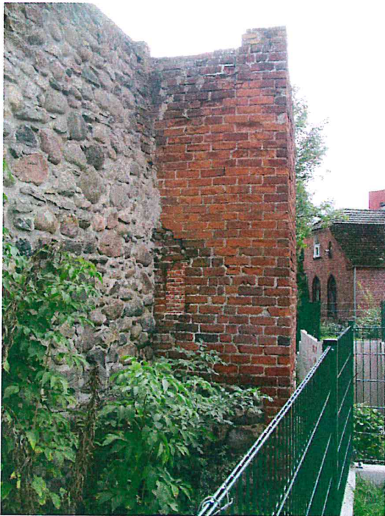
FOT.20. ZARYSOWANIA MURU OD STRONY ZEWNĘTRZNEJ DO SPIĘCIA PRĘTAMI SYSTEMOWYMI, BĄDŹ DO PRZEMUROWANIA
