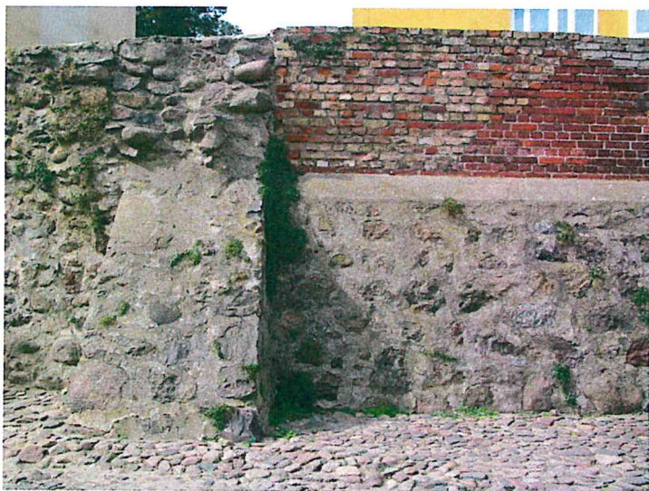
FOT.6. SPOINY DO WYMIANY, NA CAŁEJ DŁUGOŚCI MURU
