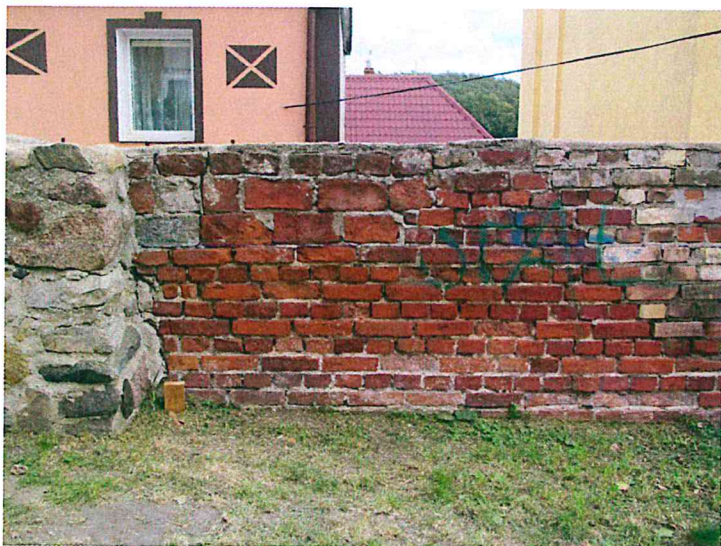
FOT.2. ZARYSOWANIA MURU DO ZSZYCIA W SYSTEMIE BRUTT SERVER
