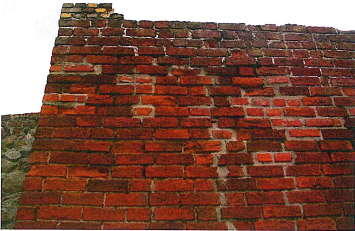
FOT.19. ZARYSOWANIA MURU OD STRONY ZEWNĘTRZNEJ DO SPIĘCIA PRĘTAMI SYSTEMOWYMI, BĄDŹ DO PRZEMUROWANIA
