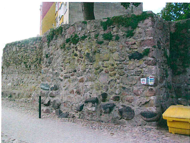
FOT.9. ZARYSOWANIA MURU SPOWODOWANE ROZSADZANIEM GO PRZEZ KORZENIE DRZEWA
