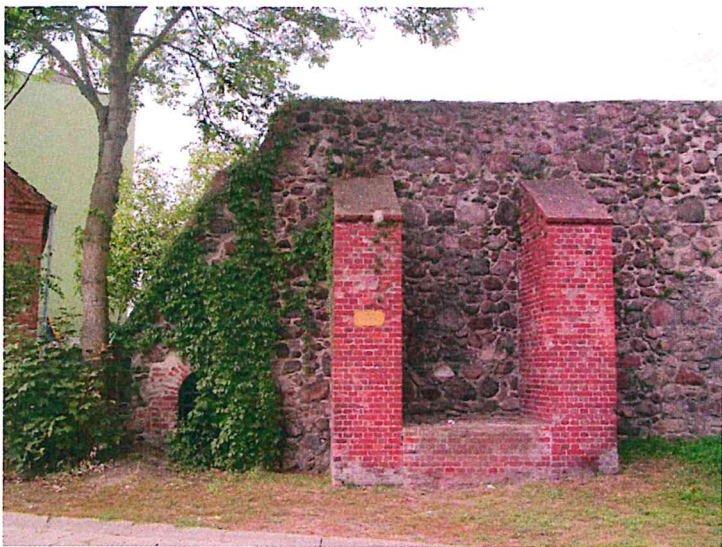
FOT.15.SPOINA CEMENTOWA DO WYMIANY NA TRASOWĄ
