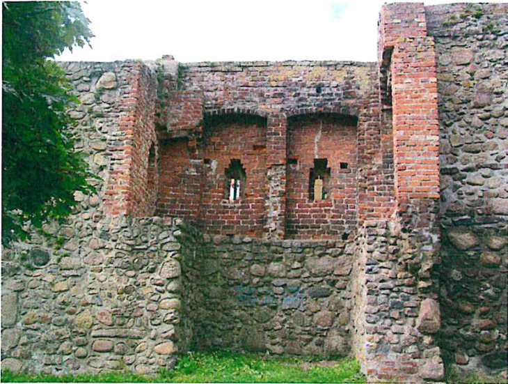
FOT.17. W WARSTWIE CEGLANEJ WIDOCZNE NAPRAWY MURU
