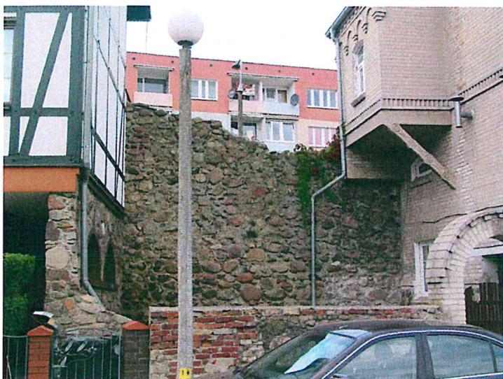
FOT.13.SPOINA CEMENTOWA DO WYMIANY NA TRASOWĄ, ROŚLINNOŚĆ DO USUNIĘCIA
