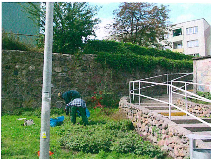
FOT.11. ROŚLINNOŚĆ PORASTAJĄCA KORONĘ MURÓW , DO USUNIĘCIA
