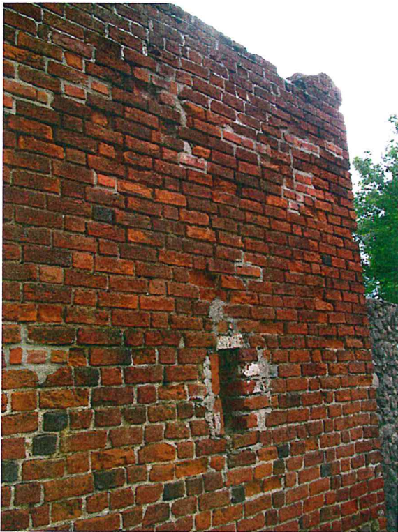
FOT.18. ZARYSOWANIA MURU OD STRONY ZEWNĘTRZNEJ DO SPIĘCIA PRĘTAMI SYSTEMOWYMI, BĄDŹ DO PRZEMUROWANIA
