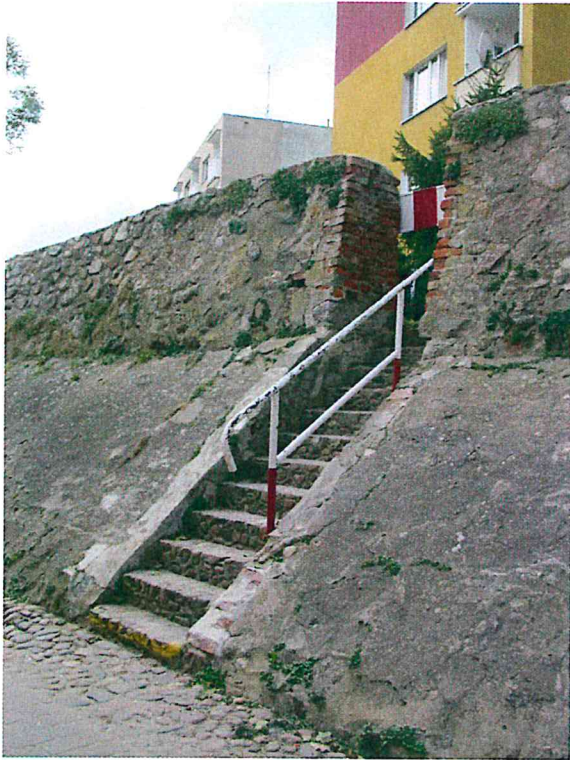
FOT.7. SPOINY DO WYMIANY, NA CAŁEJ DŁUGOŚCI MURU, SMARÓWKI CEMENTOWE DO USUNIĘCIA
