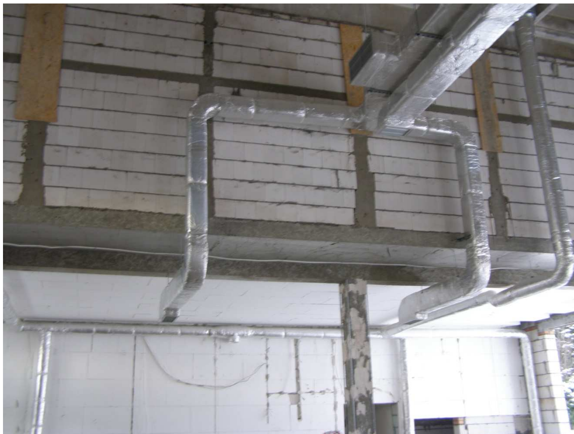
Zdjęcie nr 2 ZESPÓŁ WYWIEWNY NR W6 I NR W6B ORAZ NAWIEWNY NR N5 W POMIESZCZENIU NR 15- CZĘŚĆ WYSOKA
